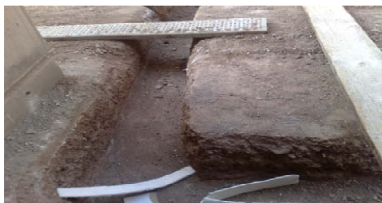
جهت اجرای فونداسیون پله
