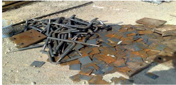
جهت اجرای فونداسیون پله
