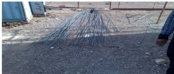
خرید آرماتور جهت اجرای دیوار دو جداره و فونداسیون پله‌ها
