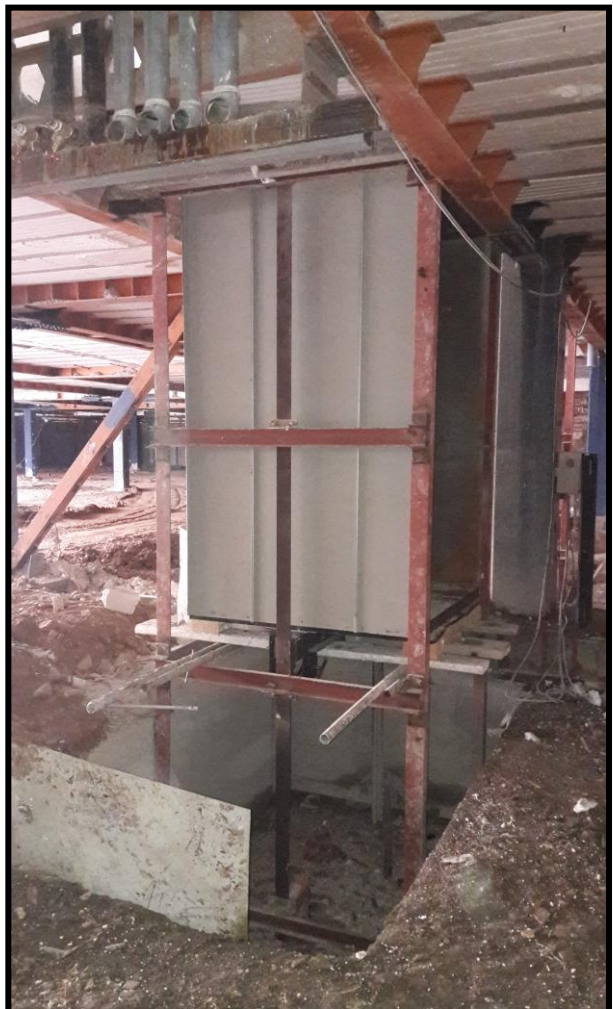
۸- نصب کابین آسانسور ۹- عملیات برشکاری و اتصال لوله‌های تاسیساتی
