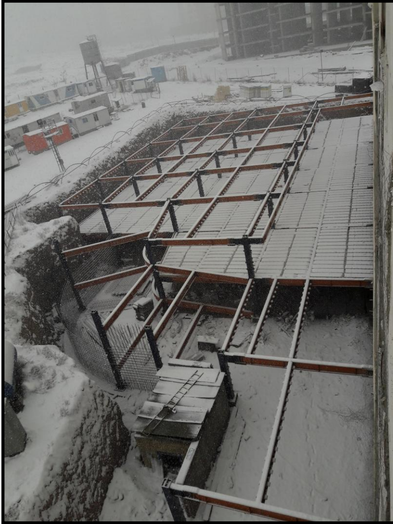
۴- اسکلت فلزی پارکینگ بلوک B:
