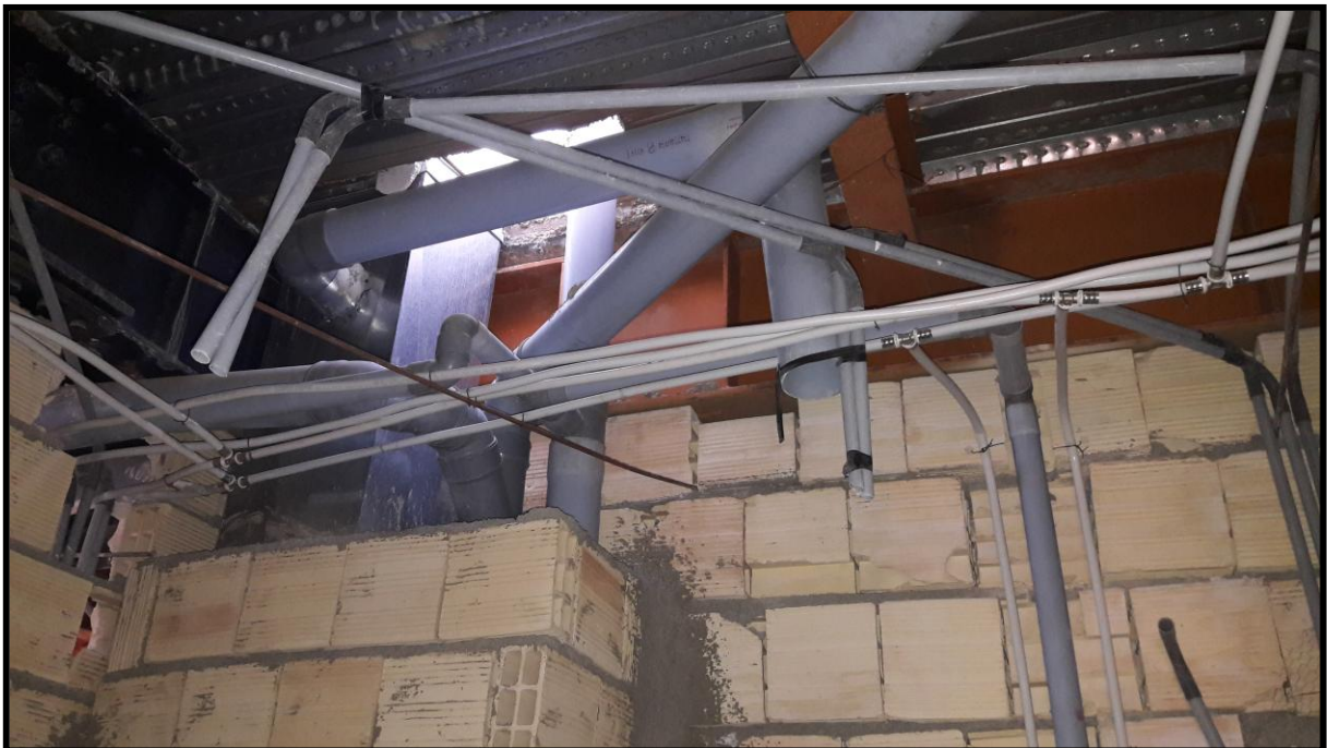
۲۶- اجرای لوله‌های تاسیسات مکانیکی واقع در بالای سقف کاذب سرویسهای بهداشتی
