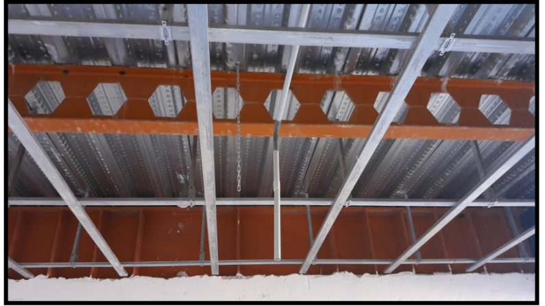
۱۱- تعبیه زنجیر آویز لوستر روشنایی
