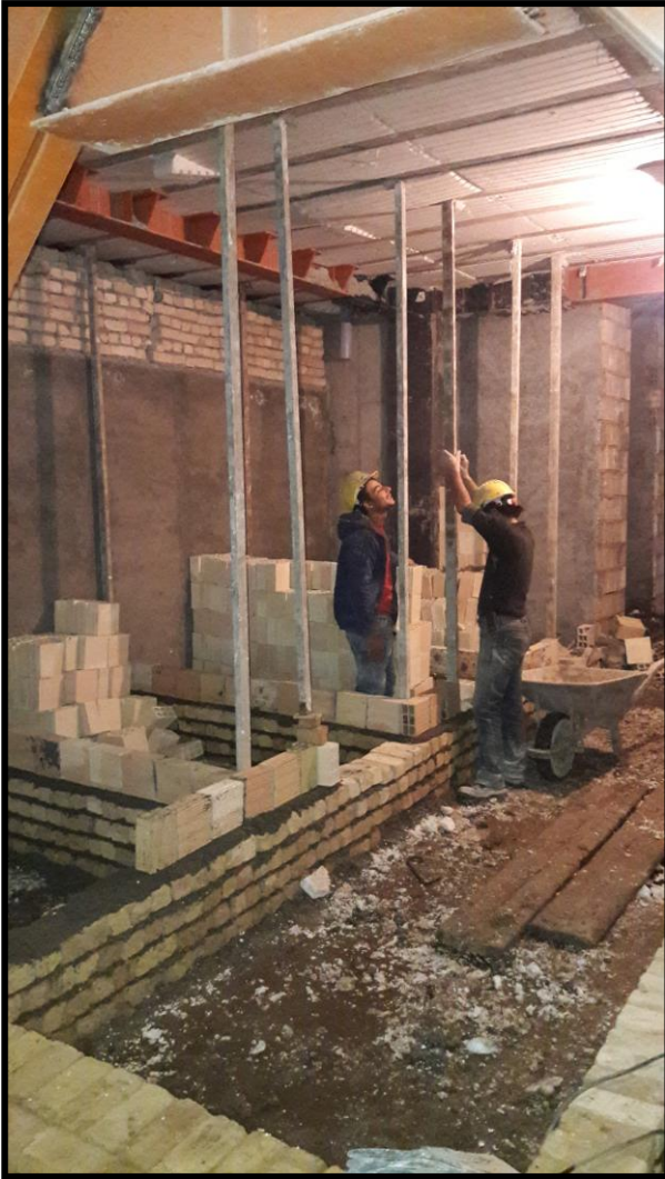
۲۷- کرسی چینی و اجرای دیوار سفالی انبار در تراز زیرزمین
