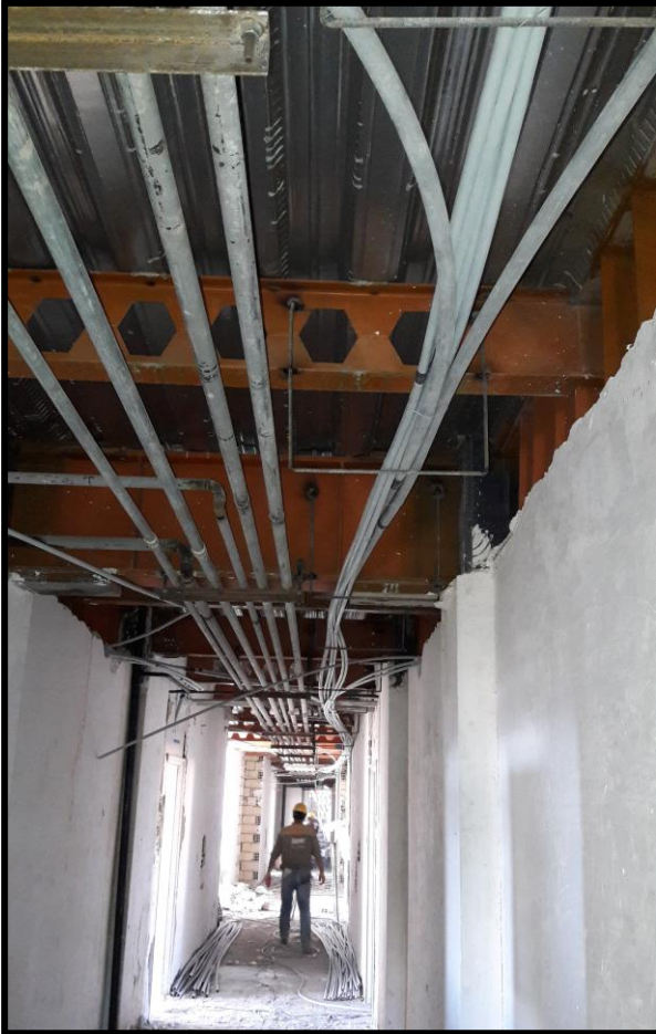
۲۵- اجرای لوله‌های افقی تاسیسات مکانیکی و برقی در سقف مشاعات
