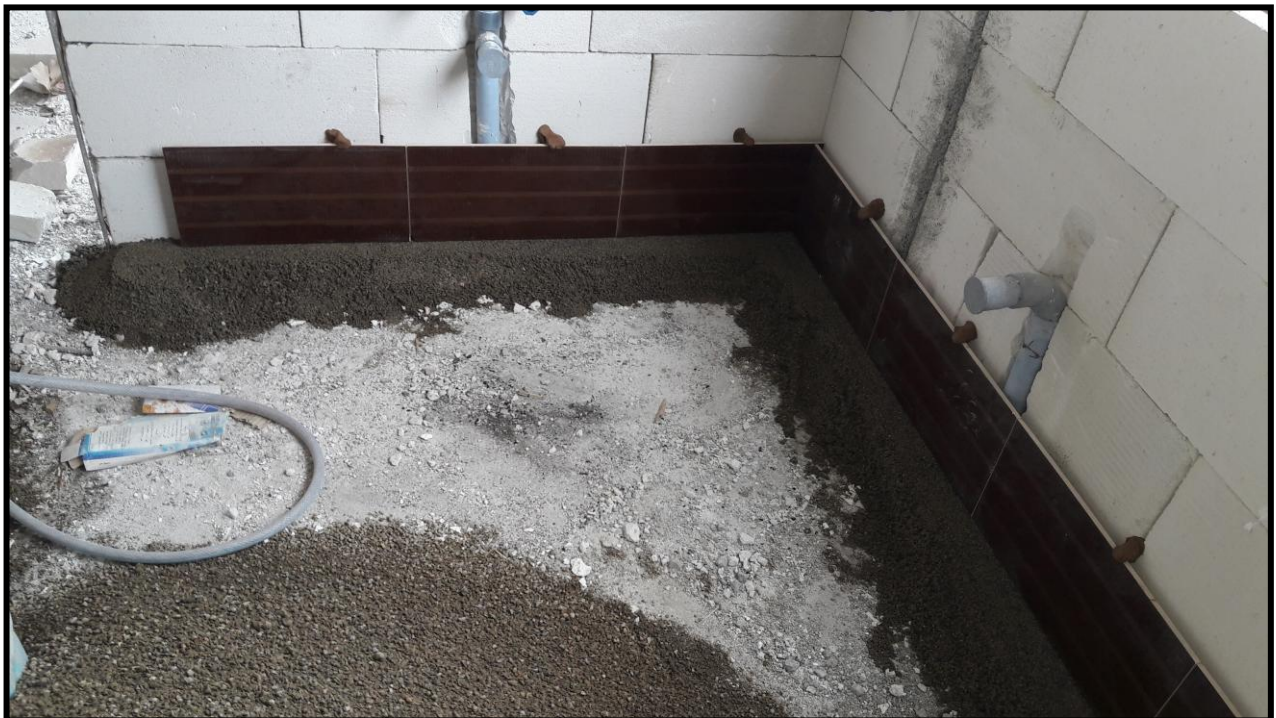
۱۲- اجرای رج اول کاشی دیوار آشپزخانه
