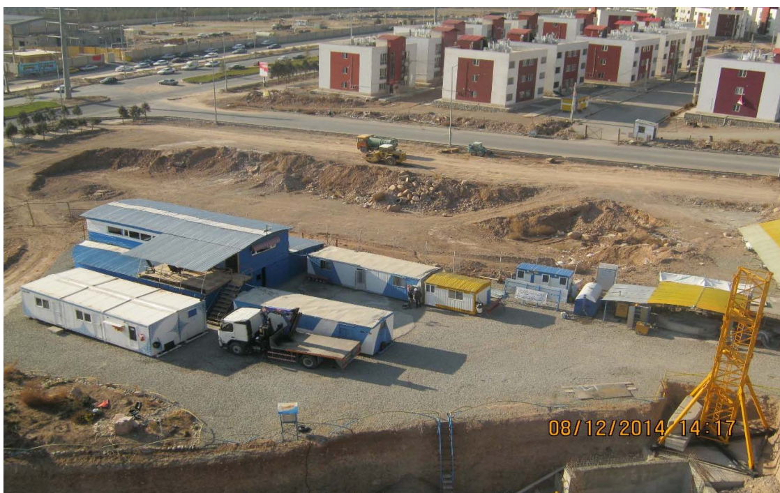
نمایی از تجهیز کارگاه - دفترهای فنی و اداری
