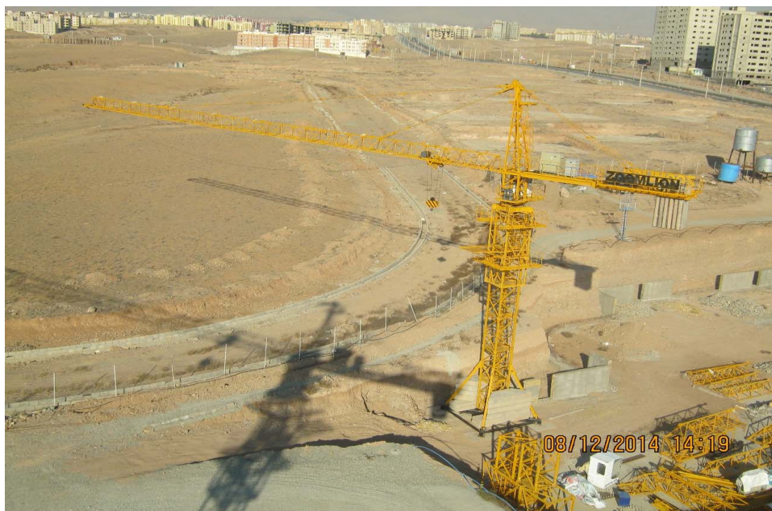
نمایی از تاور های نصب شده و فونداسیون ها
