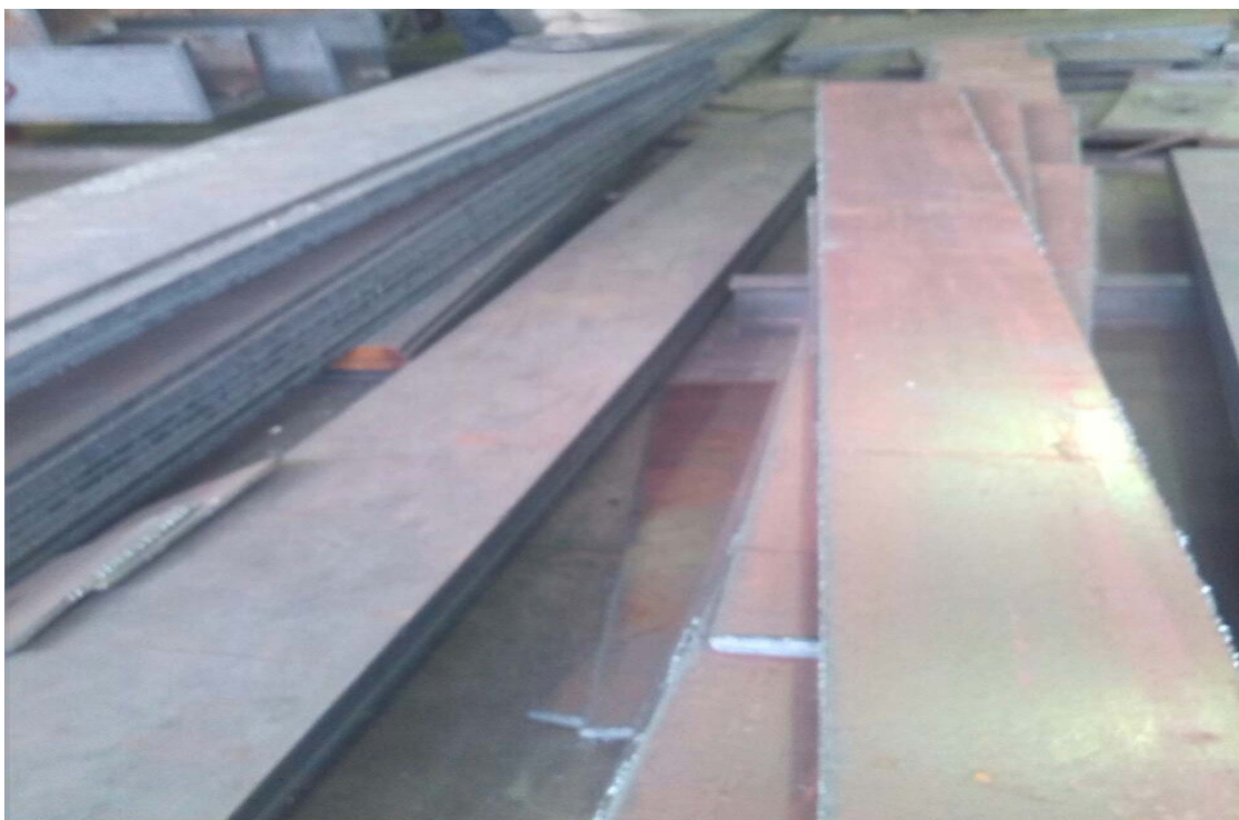
دپو ورقهای برش خورده برای ساخت قطعات اسکلت
