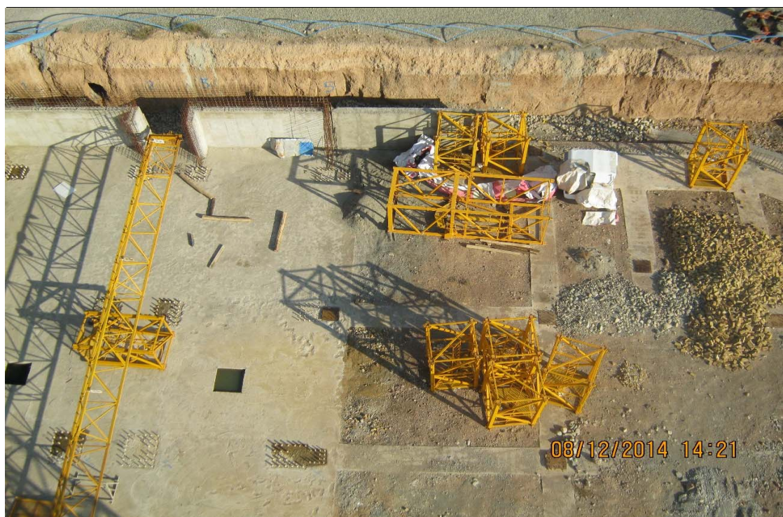
نمایی از تاور در حال مونتاژ برای نصب
