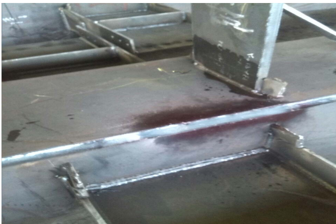
نمایی از زیرسری و دستک نصب شده روی ستونها
