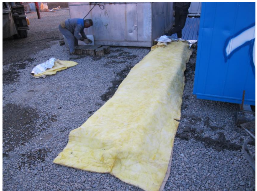
حفاظت نمونه های بتنی در محل کارگاه
