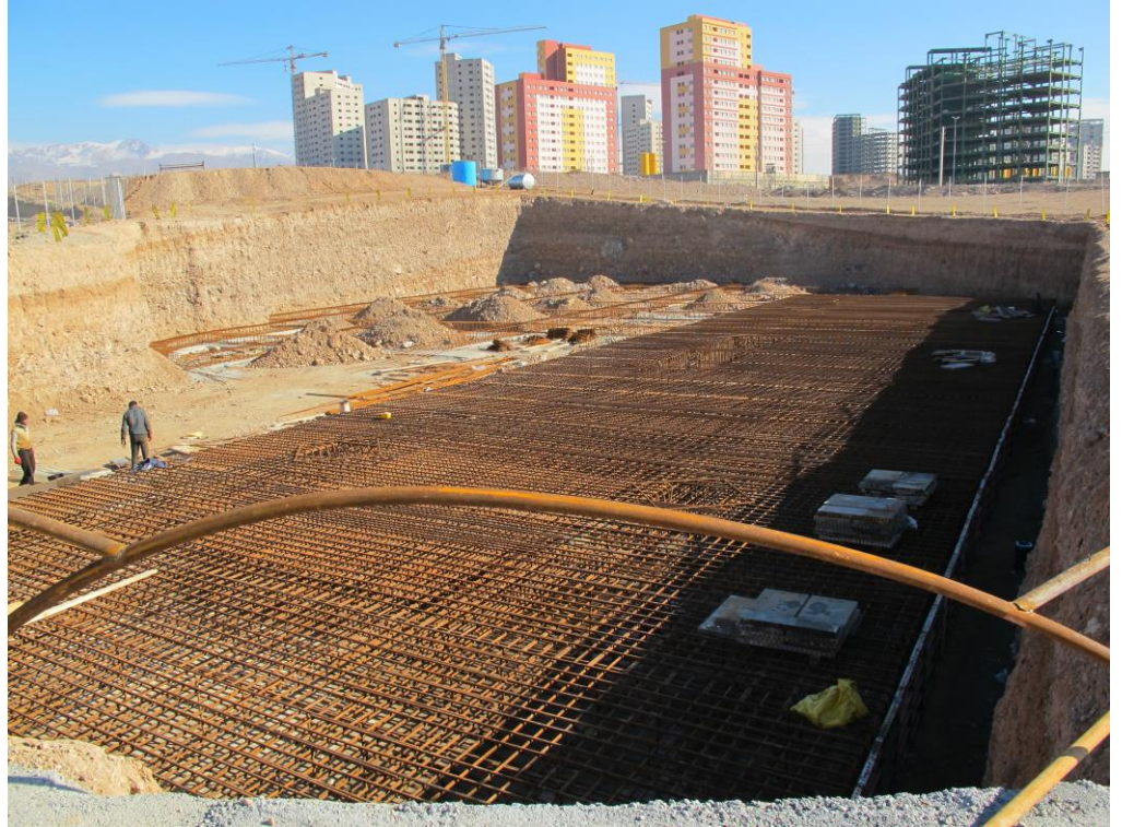
آغاز عملیات قالب بندی ضلع جنوبی فونداسیون سازه اصلی
