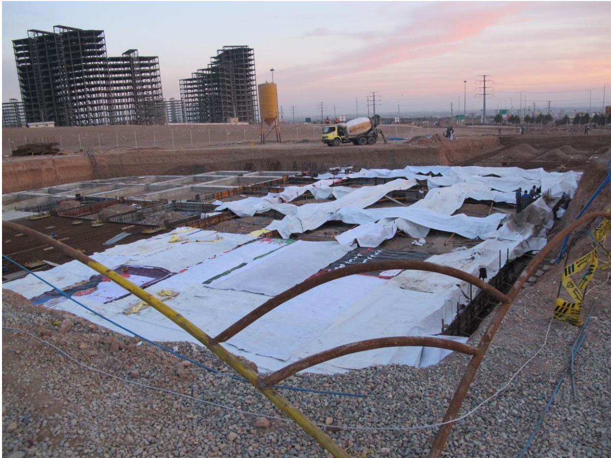
عملیات پوشش و حفاظت سطح بتن تازه پس از اتمام عملیات بتن ریزی پارت دوم فونداسیون سازه اصلی و پارکینگ
