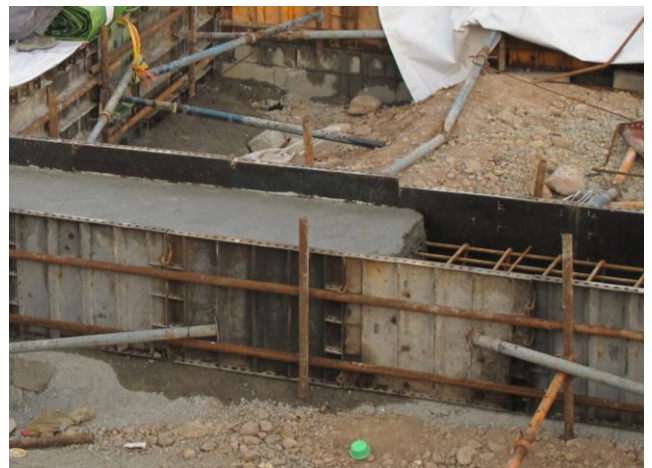
نمایی از محل درز اجرایی قبل و بعد از باز کردن رابیتس (قبل از آغاز بتن ریزی پارت مجاور)
