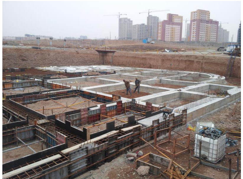
نمایی از ضلع شرقی فونداسیون سازه اصلی و پارکینگ پس از قالب برداری
