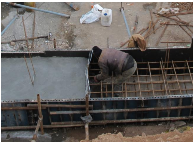
نمایی از محل درز اجرایی قبل و بعد از باز کردن رابیتس (قبل از آغاز بتن ریزی پارت مجاور)
