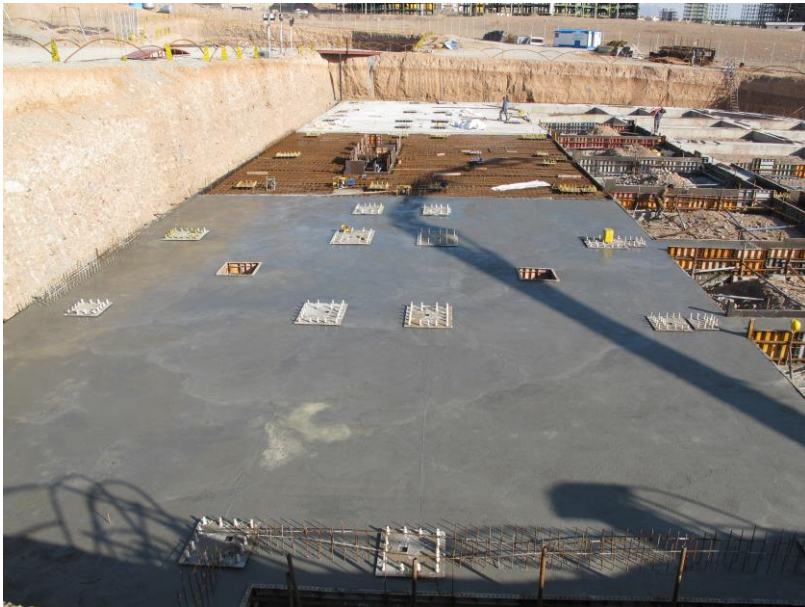
نمایی از پارت دوم فونداسیون سازه اصلی بلافاصله پس از تکمیل بتن ریزی
