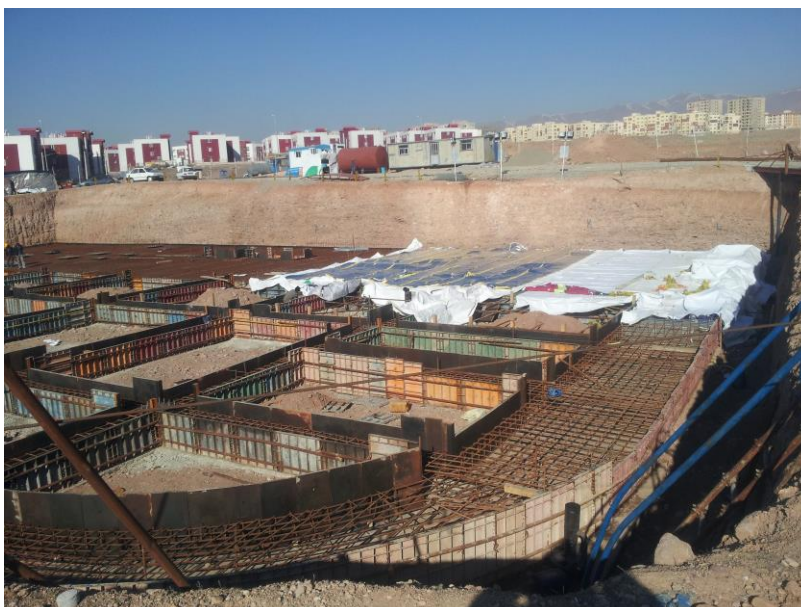
عملیات پوشش سطح بتن تازه در پارت اول فونداسیون سازه اصلی
