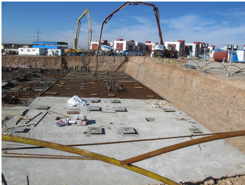
نمایی از اجرای عملیات بتن ریزی پارت دوم فونداسیون سازه اصلی (حجم بتن حدود ۳۲۰ مترمکعب)
