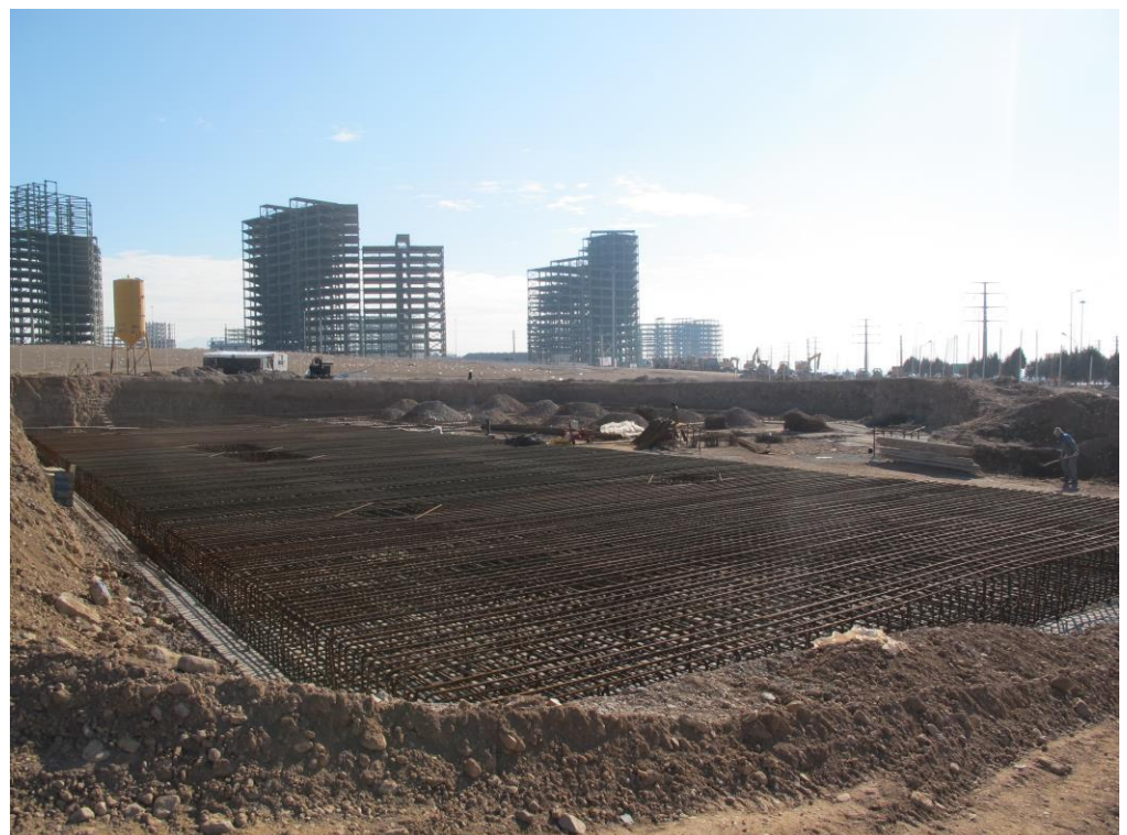
آرماتوربندی انجام شده در فونداسیون
