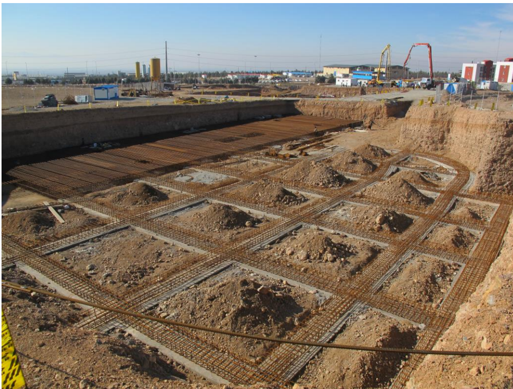
نمایی از عملیات آرماتوربندی انجام شده در فونداسیون سازه اصلی و پارکینگ
