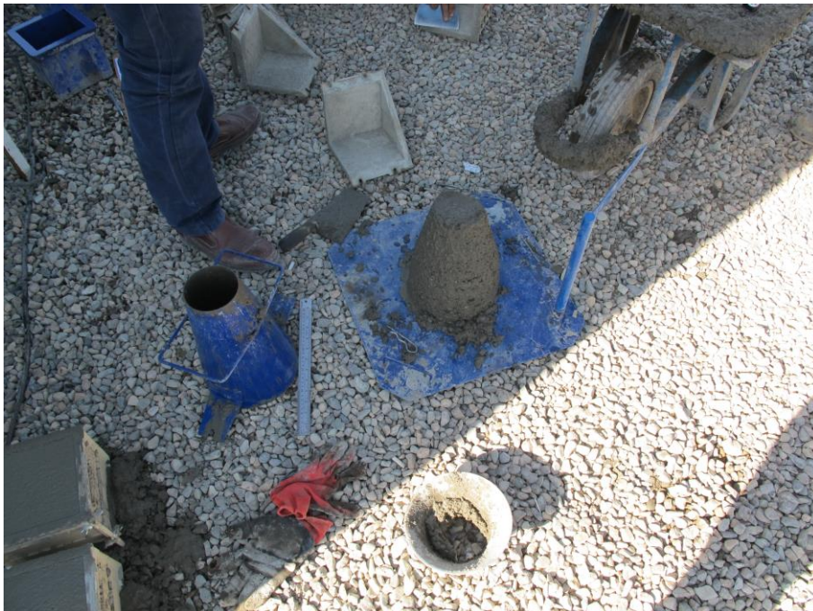
آزمایش اسلامپ (روانی بتن) در محل کارگاه
