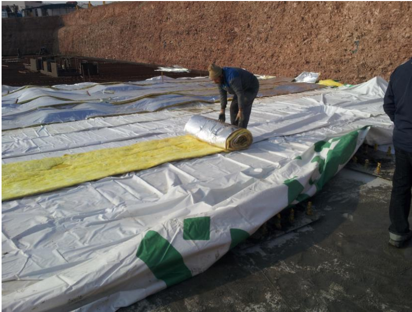
عملیات برچیدن لایه محافظ بتن ریزی پارت اول فونداسیون سازه
