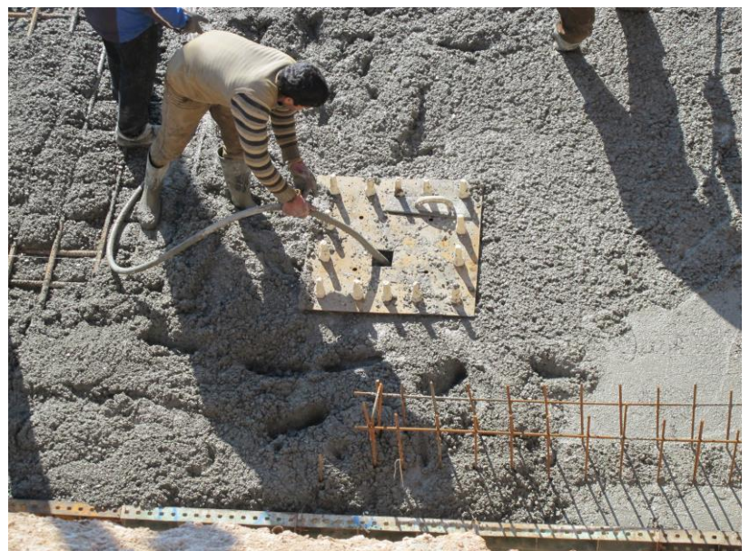
عملیات ویراسیون از درون سوراخ تعبیه شده درون شابلونهای بیس پلیتهای فونداسیون سازه اصلی
