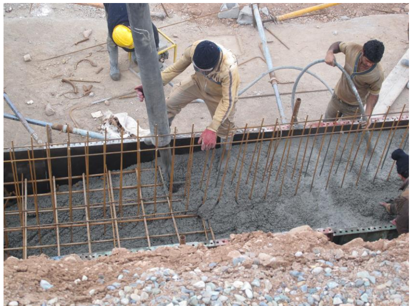
عملیات بتن ریزی پارت دوم فونداسیون سازه پارکینگ
