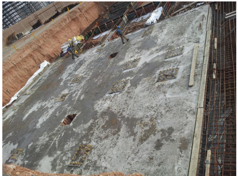
پارت اول فونداسیون سازه پس از برداشتن پوشش حفاظتی
