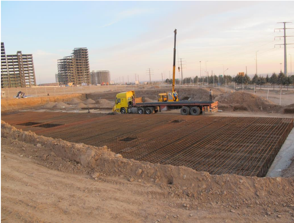
عملیات تخلیه آخرین محموله میلگرد مورد نیاز جهت تکمیل فونداسیون
